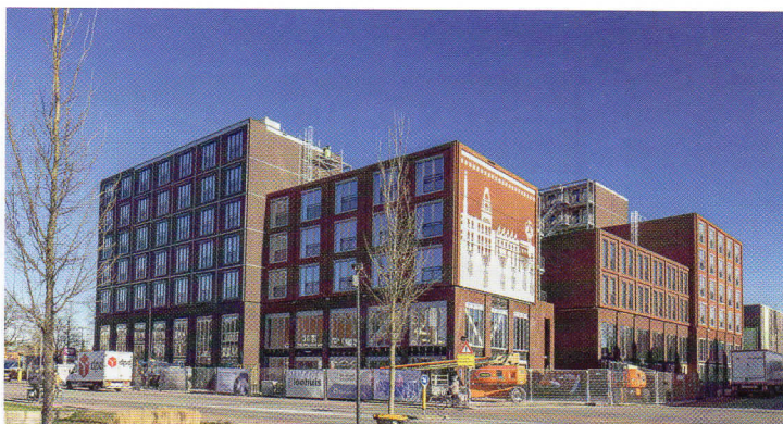
Het eerste Bundle-project verrijst in Enschede. (foto's Vechtdal Wonen)
