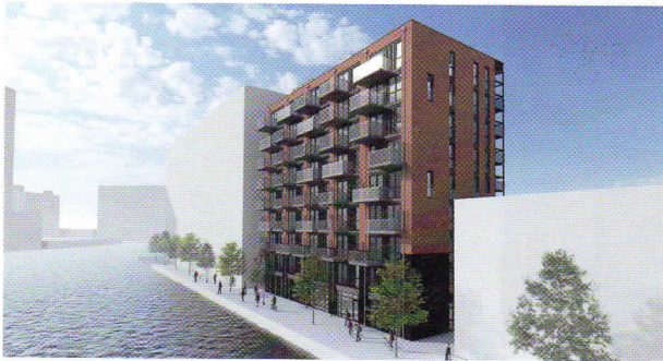
De Regie heeft een CPO ondersteund bij de ontwikkeling van dit appartementencomplex in de Petroleumhaven in Den Haag, met aan de waterzijde een gemeenschappelijk dakterras. (foto De Regie)
